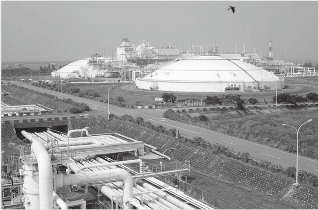
圖5.中油永安天然氣地下式儲槽
