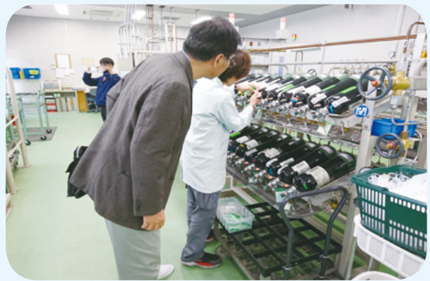
現場工作人員標示醫用氣體作業
