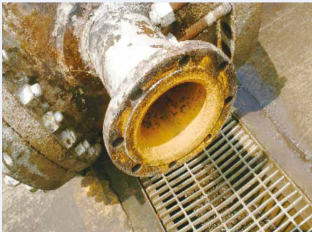
圖6.管線作業須注意殘存內容物之危害
