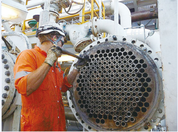
圖8.清除危險有害內容物，作業者應佩戴適當防護具
