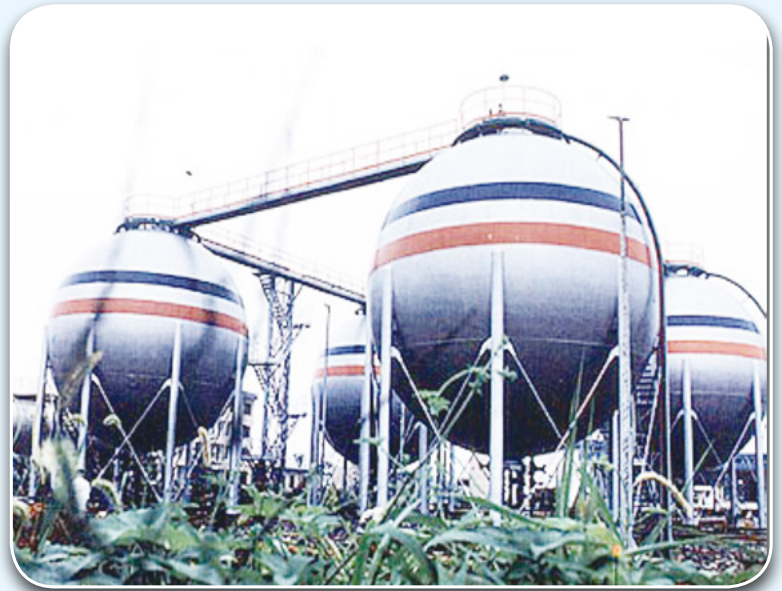
圖4.液化石油氣球型槽
