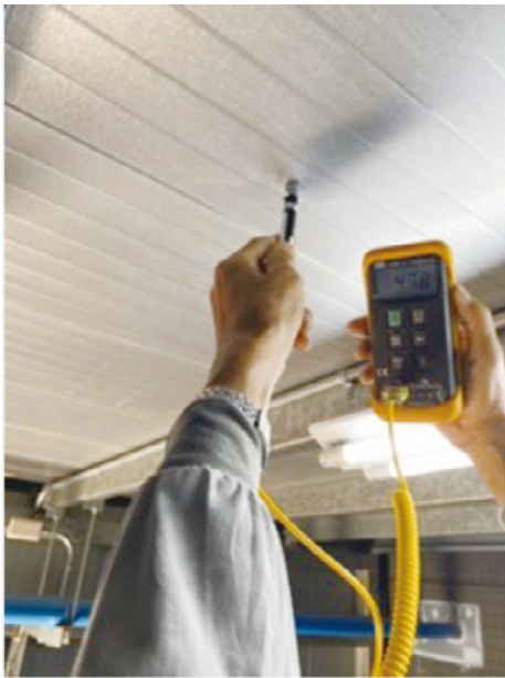
塗布前，室內屋頂量測溫度48°C
