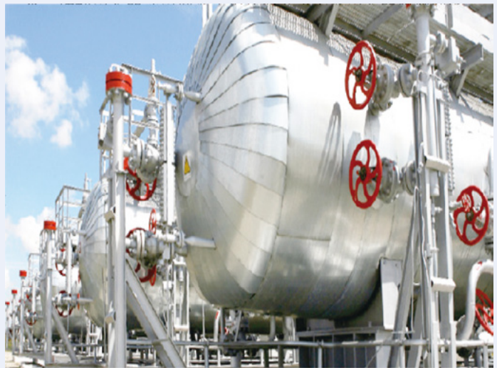
圖10. 安全閥、流量計的確認
