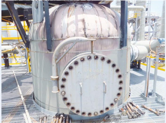
圖11. 熱拴緊、冷拴緊，可防止外洩
