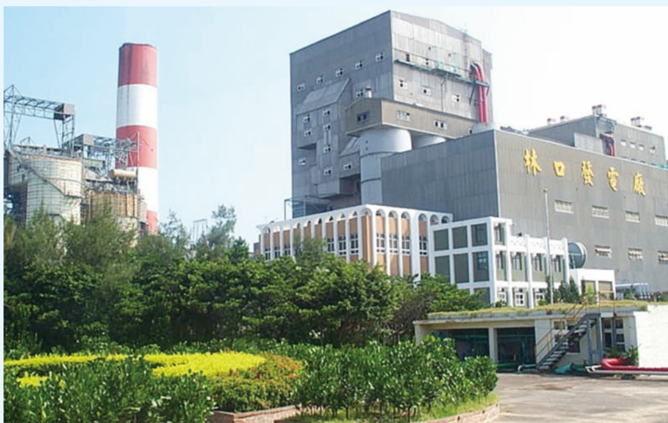
照片:林口發電廠擁有台灣首部超超臨界燃煤機組
