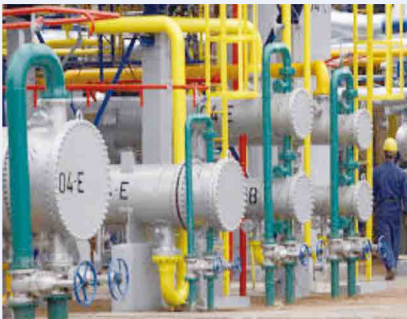
圖7.配管及閥等堆積的堵塞物應採取較安全方式去除
