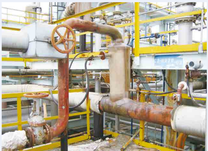
圖6. 如用鐵絲清除堵塞物時，內容物會急速噴出
