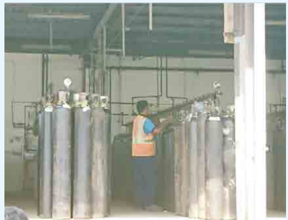
Air Products現場人員操作鋼瓶灌充情形
