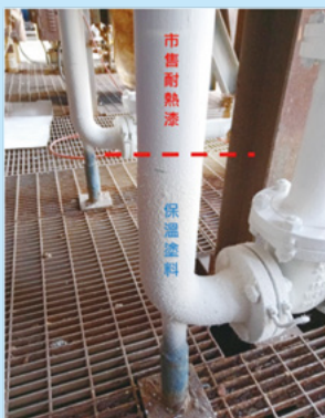
照片說明：市售耐熱漆與陶瓷保溫塗料，實際量測溫度的差異比較。
