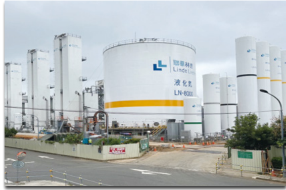
空氣分離工場(冷箱、超低溫儲罐)
