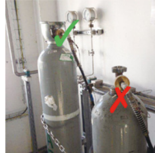
圖一、左方鋼瓶防甩纜線確實勾掛在瓶閥上，右邊鋼瓶未確實勾掛防甩纜線
